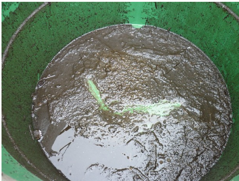
XXXX photo 163 : Sans filtre en entrée, ce fond de cuve est déjà bien envasé au bout d'une année seulement avec un toit de moins de 30 m 2 !
