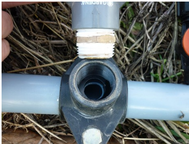
XXXX photo XX : Exemple de connexion rapide visée sur un « collier de prise en charge ».
